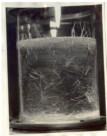
Obr.4: Ukládání vláken sedimentací ve vodě
